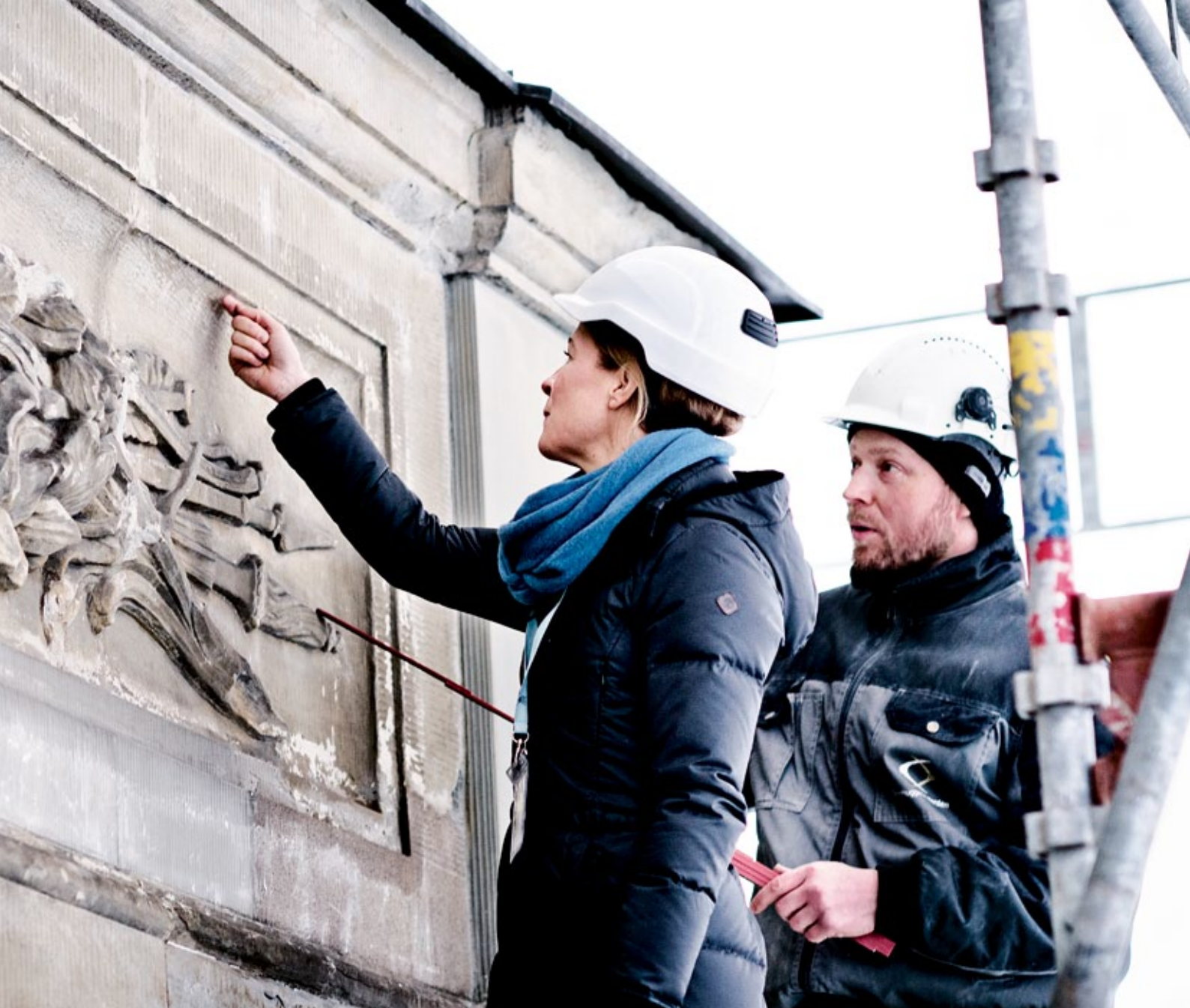
Malin Myrin och stenhuggaren Niclas Johansson granskar de vittrande relieferna på rundflyglarnas balustrader vid den yttre borggården.
